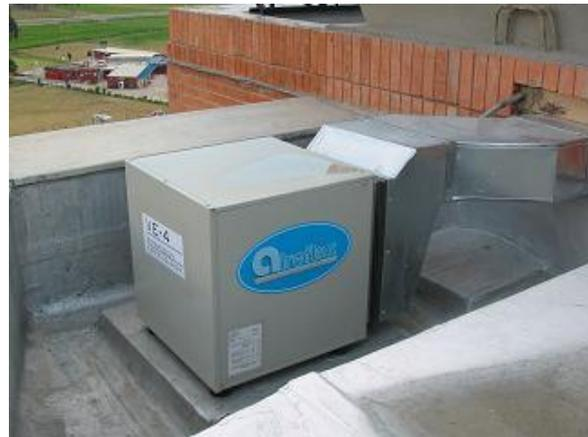
**Unidad Ventiladora con un solo ventilador**
